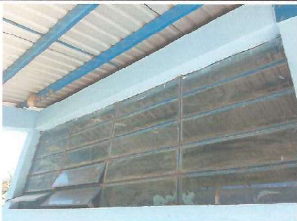
Foto 1: Mejoramiento de ventanas
