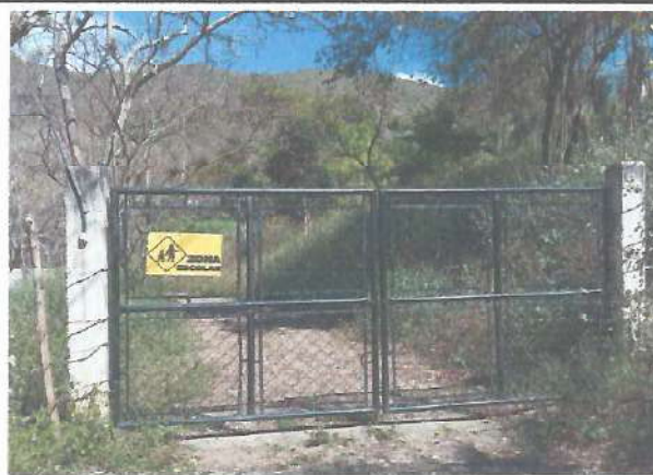
Foto 4: Mantenimiento a portones
