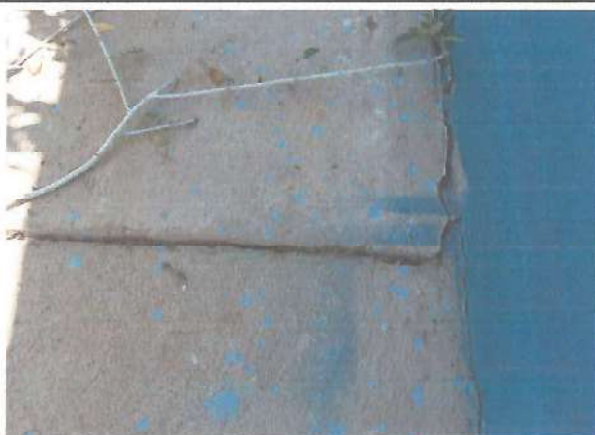
Foto 3: Losa de patio
