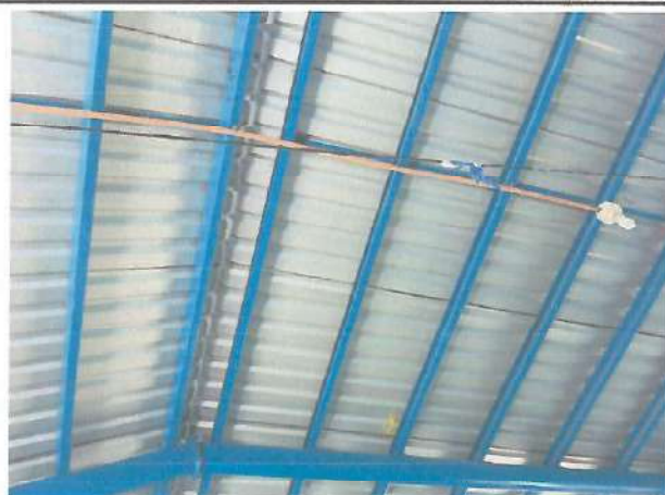
Foto 2: Reparación de sistema eléctrico
